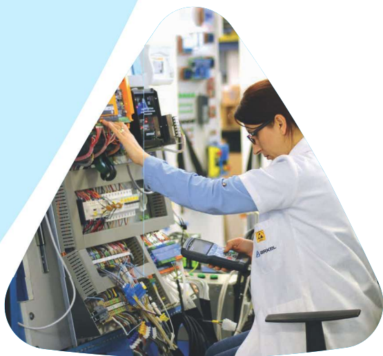
VEZAVA PANELOV PANEL WIRING
